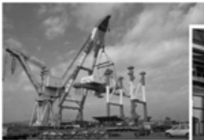
大型クレーン
