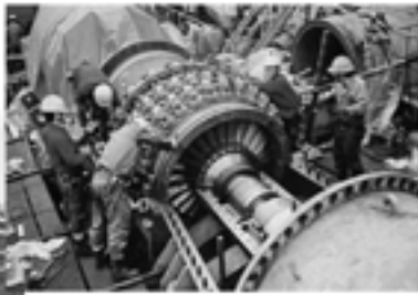
蒸気タービンの整備
